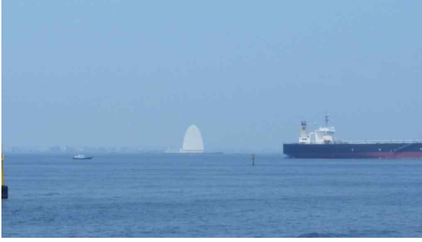
환기 및 실드 TBM의 시작점으로 사용 중인 KAZENO TOU
