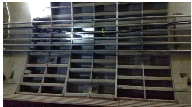
향후 연결통로로 건설될 예정으로 현재는 콘크리트가 아닌 철골 구조물로 시공
