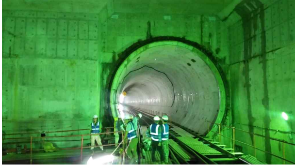
TBM의 중간 지점, 향후 집수정 및 환기구로 활용
