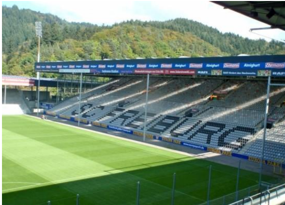
지붕에 태양광 패널이 설치된 바데노바 경기장
