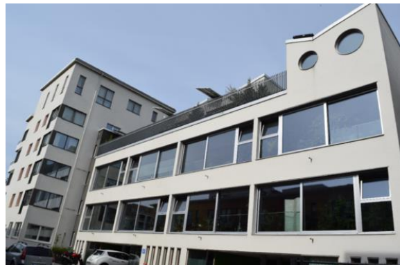
태양광 발전 설비
